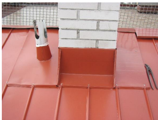
Střešní krytina, oplechování komína
